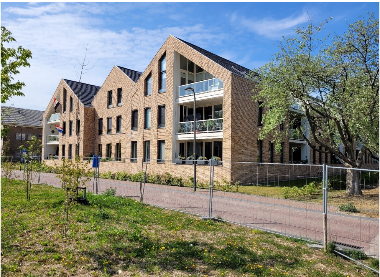
Afb. 17: nieuwbouw appartementen op SSK in lichte kleur baksteen en gesegmenteerde kapvorm
